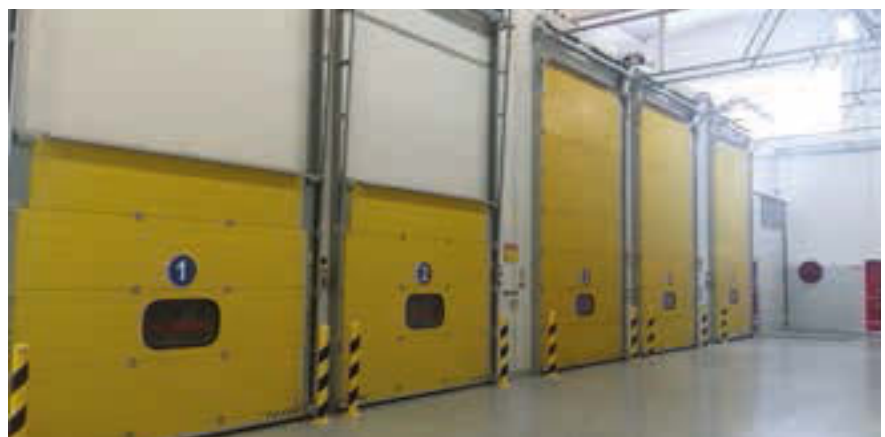
SD Logistica, interno dello stabilimento di Formica di Savignano (MO)
